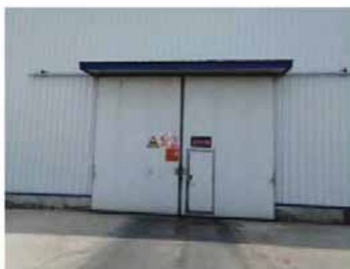
危废暂存库房
